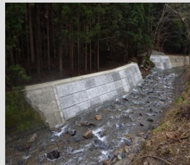
護岸工事後、石を並べ直し水中生物に配慮した環境整備
