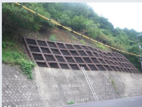
上瀬法面工事
