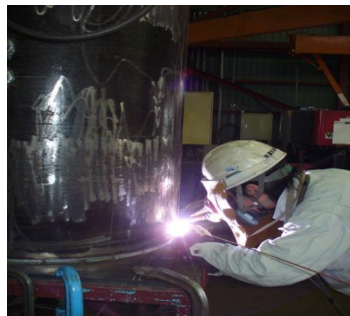
(溶接作業の様子)
