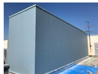
塗装工事实施
