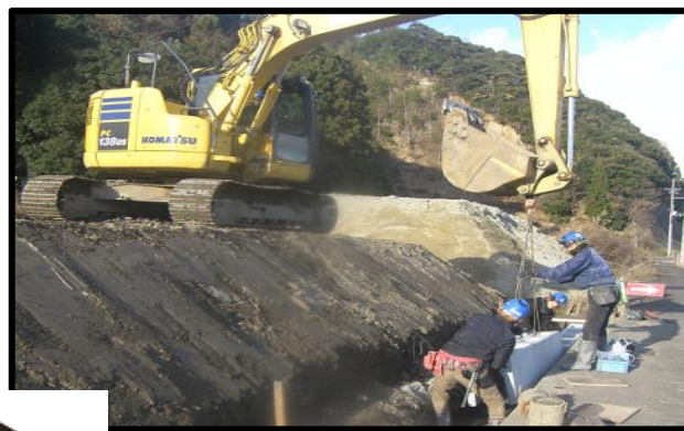
↑土木工事現場の様子
