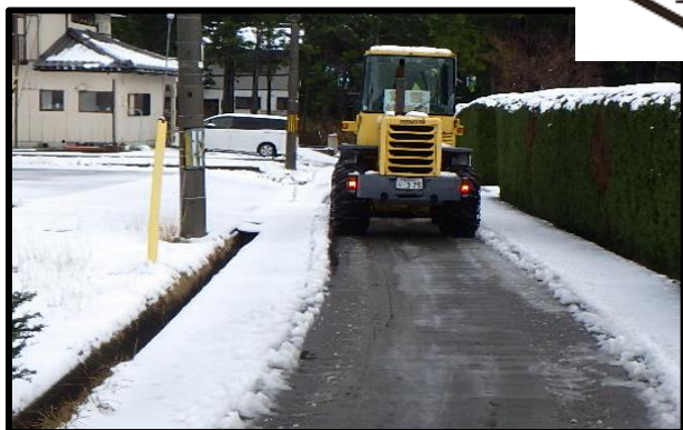
↑除雪作業の様子
