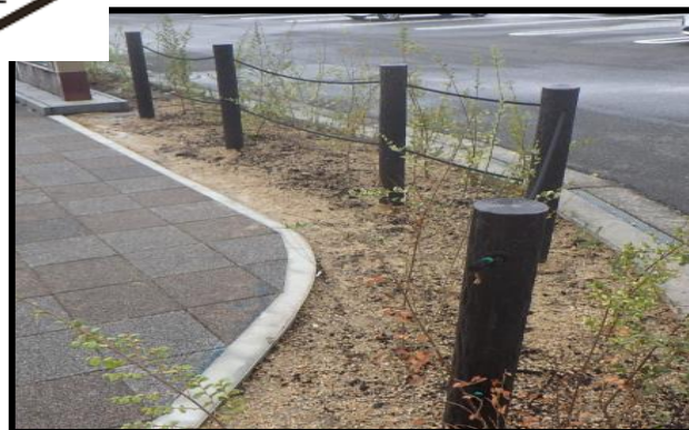
↑植栽・整備工事
