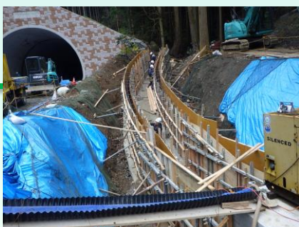
作業現場風景
