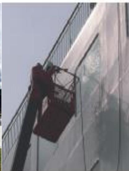
大型フェリー客室窓ガラスの塩害処理。ガラス面研磨後コーティング処理により易洗性発揮。
