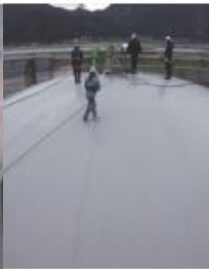
原子力発電所原子炉本体屋根部塗装後、塩害対策としてバリアクリスタル施工。
