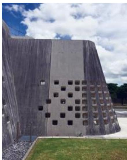
コンクリートに試験施工して、24か月後の観察事例。施工部分(中央の白い地肌)が防汚効果発揮！
