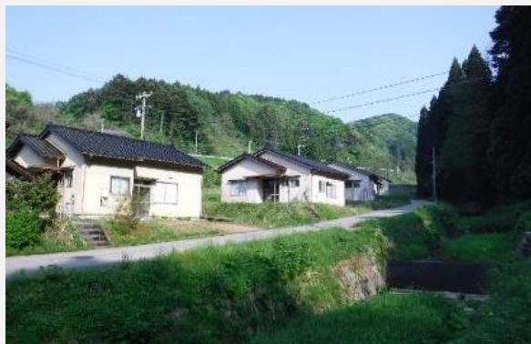
中能登町芹川18部17番地 (町営 芹川住宅)
