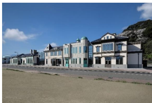
令和元年度 優良工事表彰 人道の港敦賀ムゼウム新築工事 特定建設工事JV
