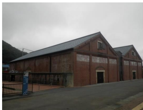
平成27年度 優良工事表彰 赤レンガ倉庫改修建築その1工事
