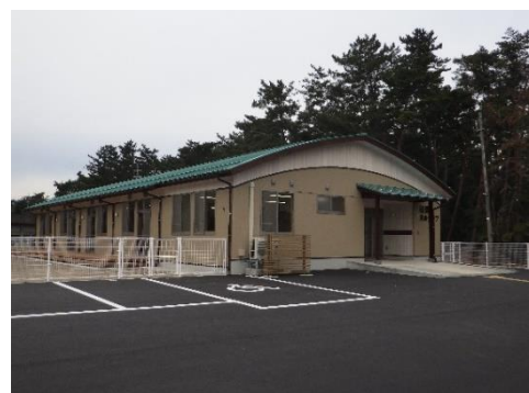
平成30年度 優良工事表彰 松原放課後児童クラブ新築工事
