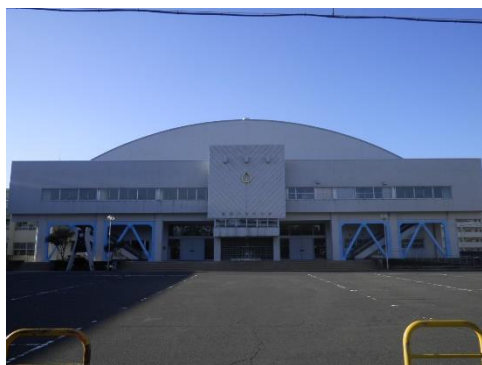
平成25年度 優良工事表彰 市立体育館耐震補強建築工事
