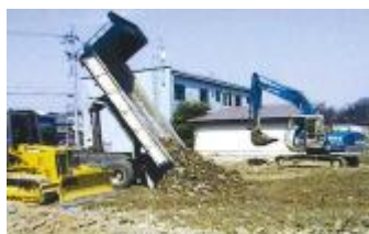
宅地造成工事
