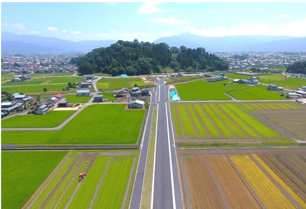
一般国道476号大野市犬山 舗装工事
