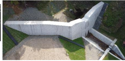
美の越川砂防工事
