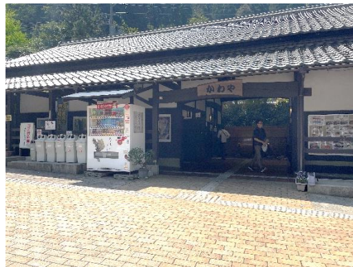
「道の駅 若狭熊川宿」のトイレ前通路に設置予定
