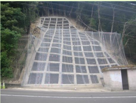
畑村法面工事
