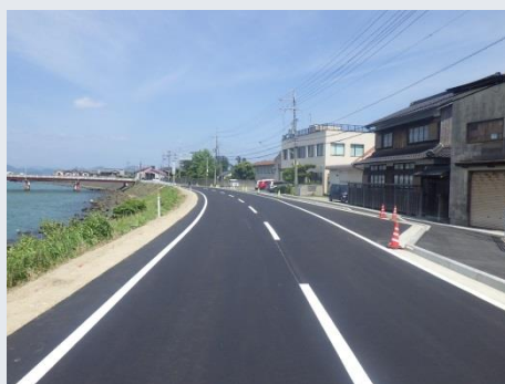
城内道路改良工事
